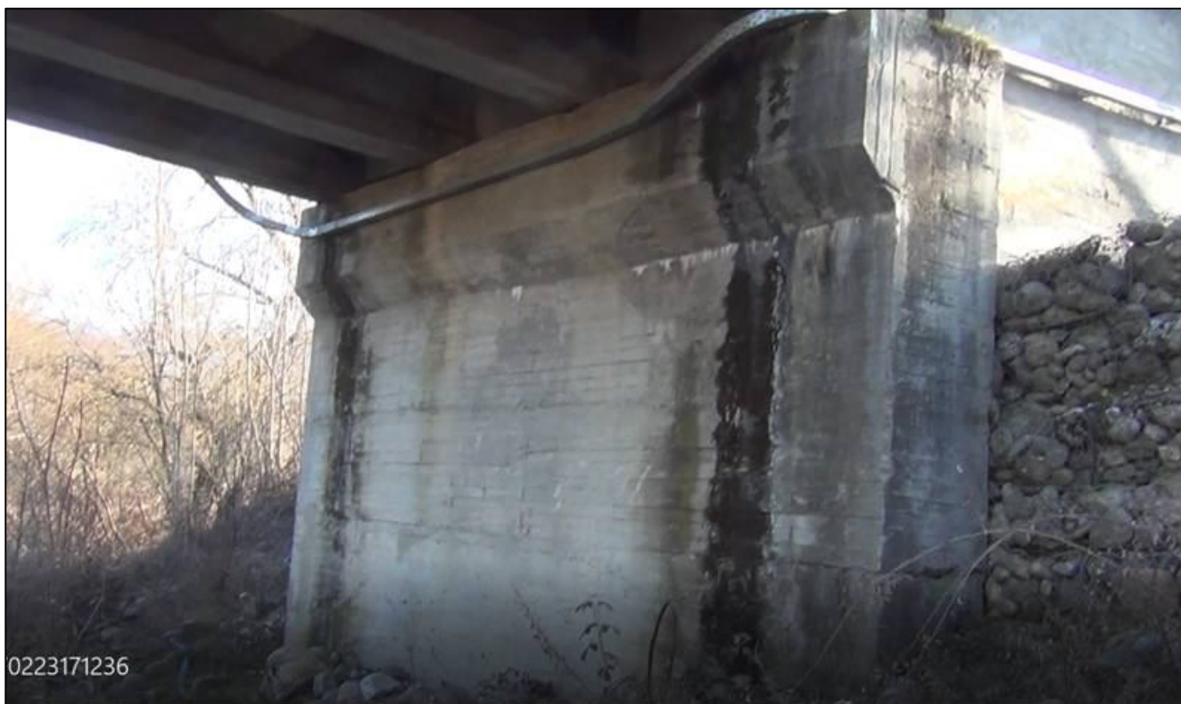
Φώτο 10: Όψη ακροβάθρου προς Δράμα. Εντοπισμένη διάβρωση λόγω αποχέτευσης.
