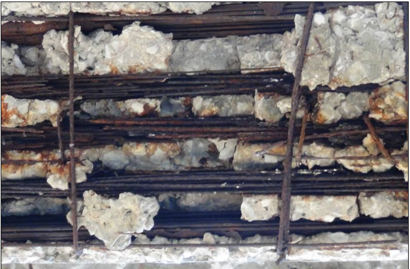
Φώτο 8: Κάτω παρειά δοκού σε θέση εκτίναξης επικάλυψης και διάβρωσης τενόντων. Διακρίνονται κομμένα σύρματα λόγω οξείδωσης. Απόμειξη σκυροδέματος.
