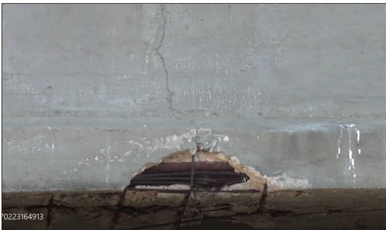
Φώτο 4: Κατακόρυφη ρωγμή δοκού εντοπισμένη σε θέση διάβρωσης τενόντων.
