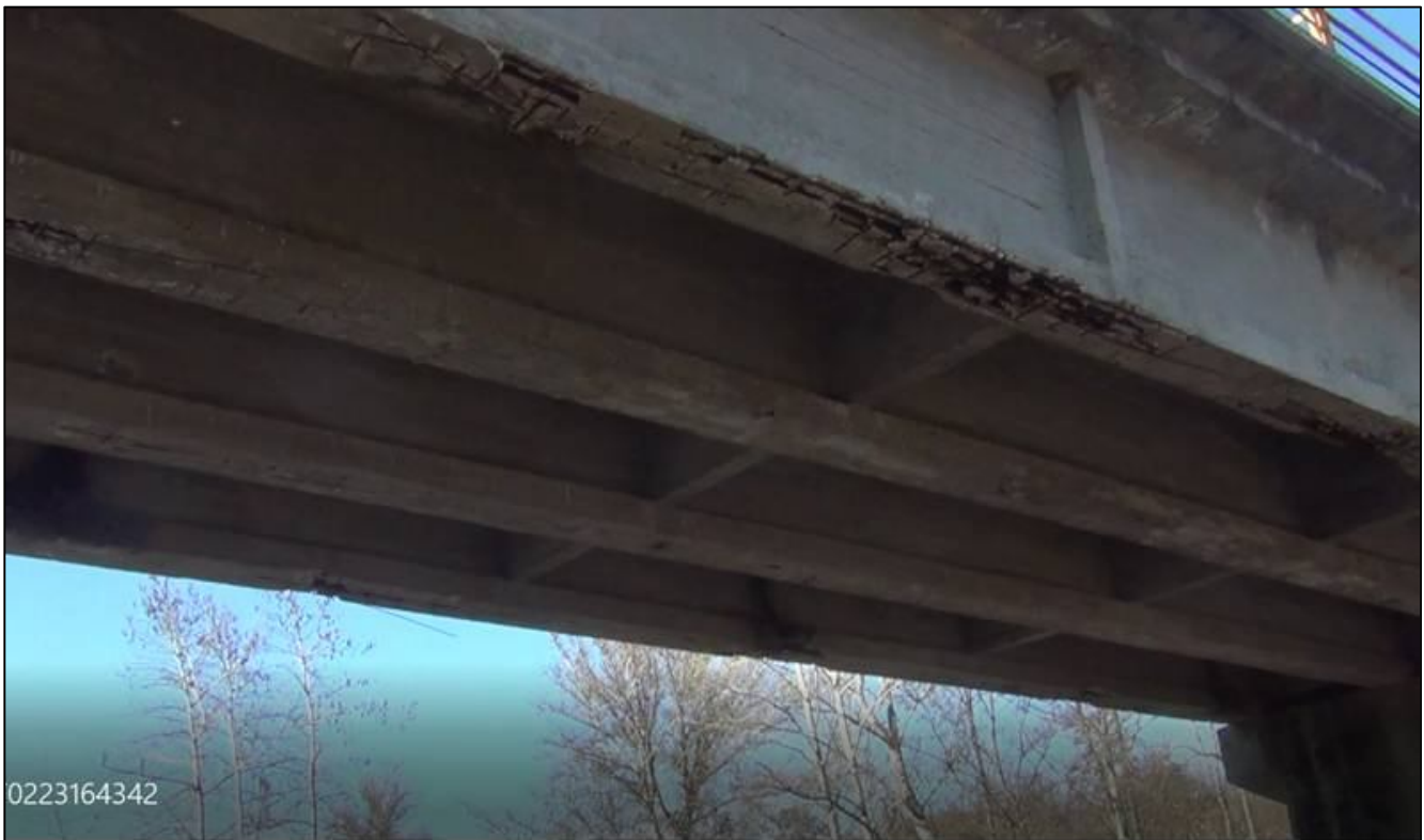
Φώτο 2: Εκτινάξεις επικαλύψεων, οξείδωση και θραύση συρμάτων τενόντων, ρηγματώση διατομής στο μέσον και στα τέταρτα.
