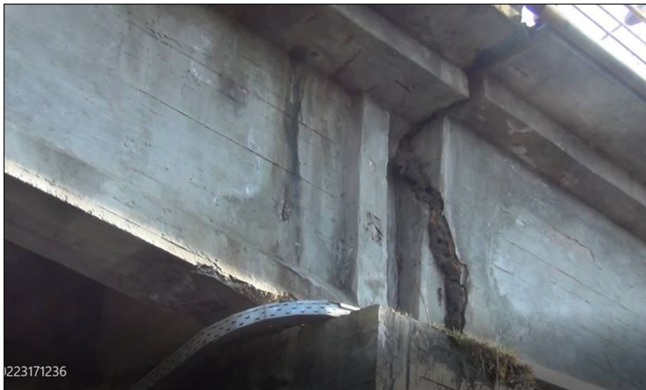
Φώτο 11: Ακρόβαθρο προς Δράμα. Θραύση και στροφή πτερυγότοιχου ανάντη.
