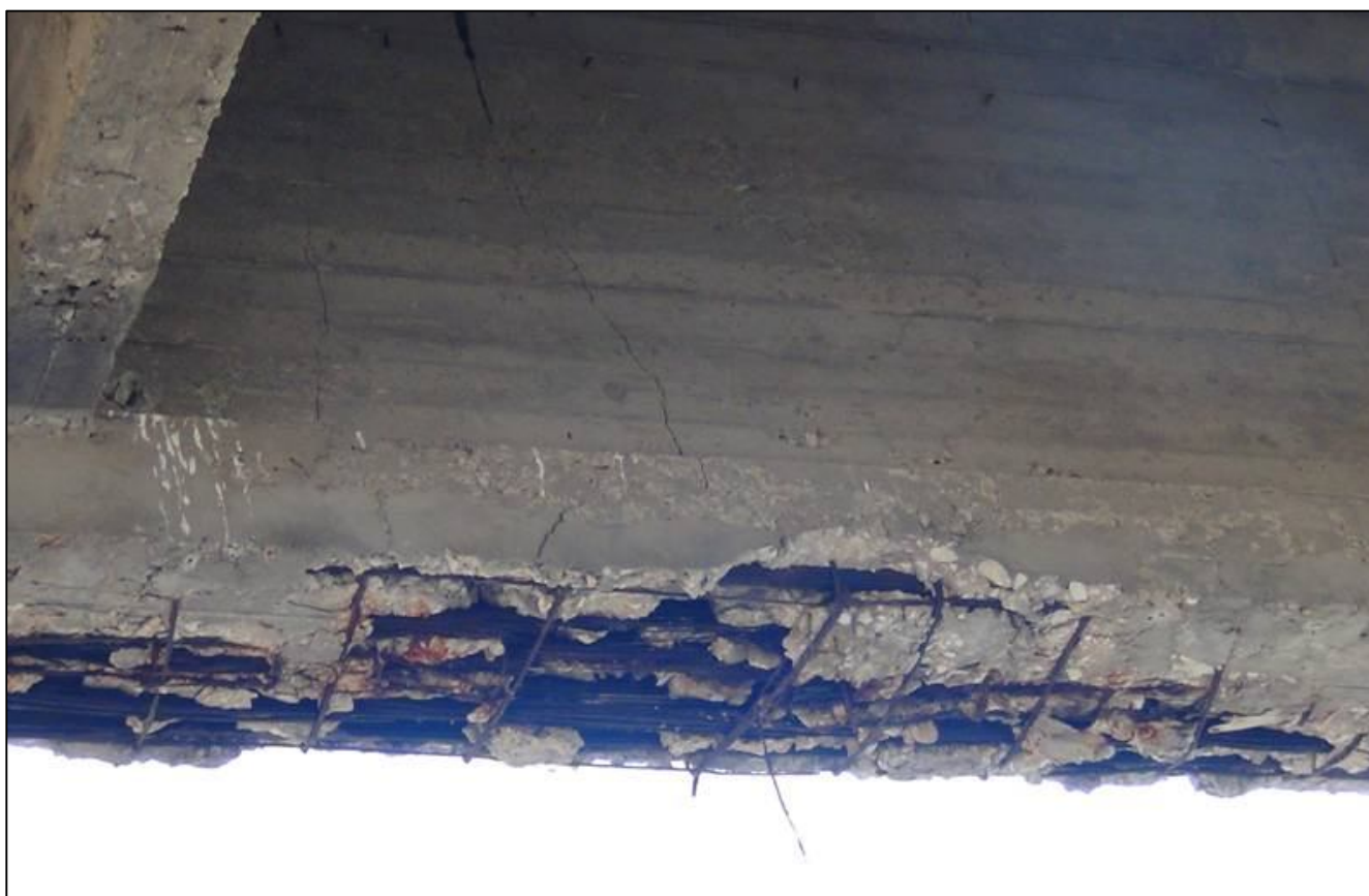
Φώτο 6: Κατακόρυφες ρωγμές δοκού εντοπισμένες σε θέσεις διάβρωσης τενόντων.
