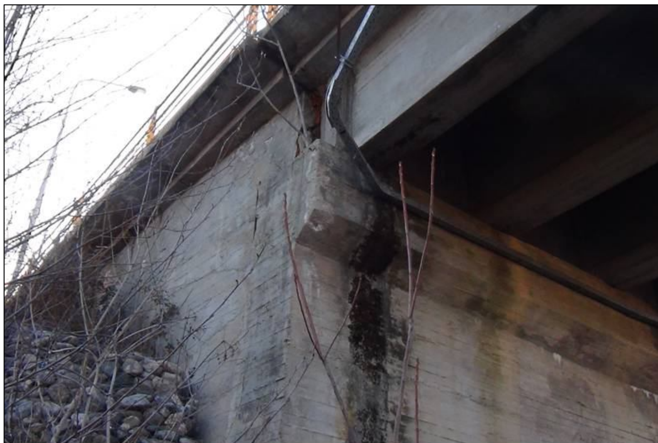
Φώτο 12: Ακρόβαθρο προς Δράμα. Θραύση και στροφή πτερυγότοιχου κατάντη.
