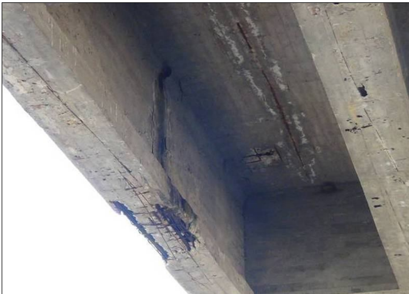
Φώτο 3: Διάβρωση δοκού εντοπισμένη σε θέση αποχέτευσης καταστρώματος. Τυπική και συστηματική βλάβη.
