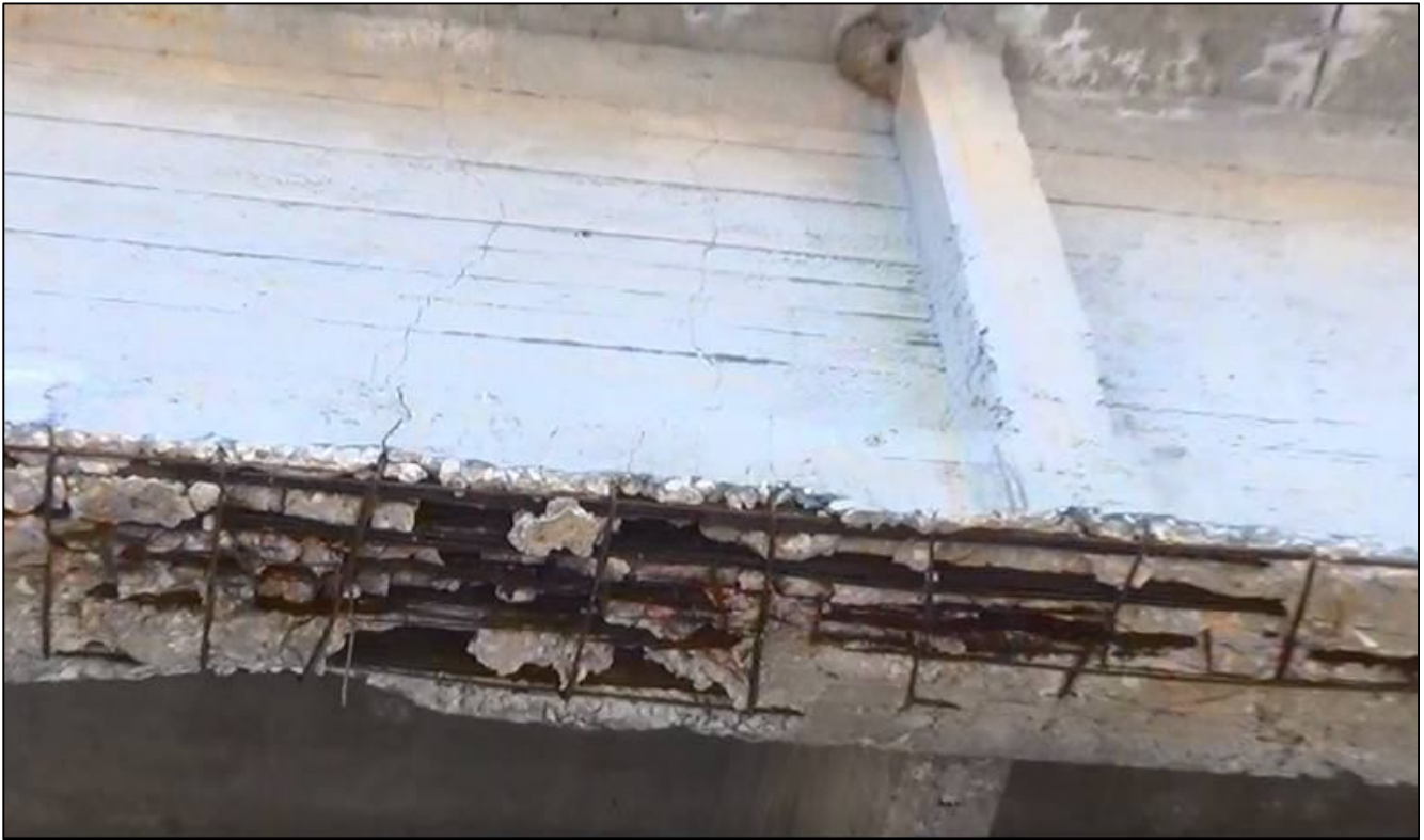
Φώτο 7: Κατακόρυφες ρωγμές δοκού εντοπισμένες σε θέσεις διάβρωσης τενόντων.
