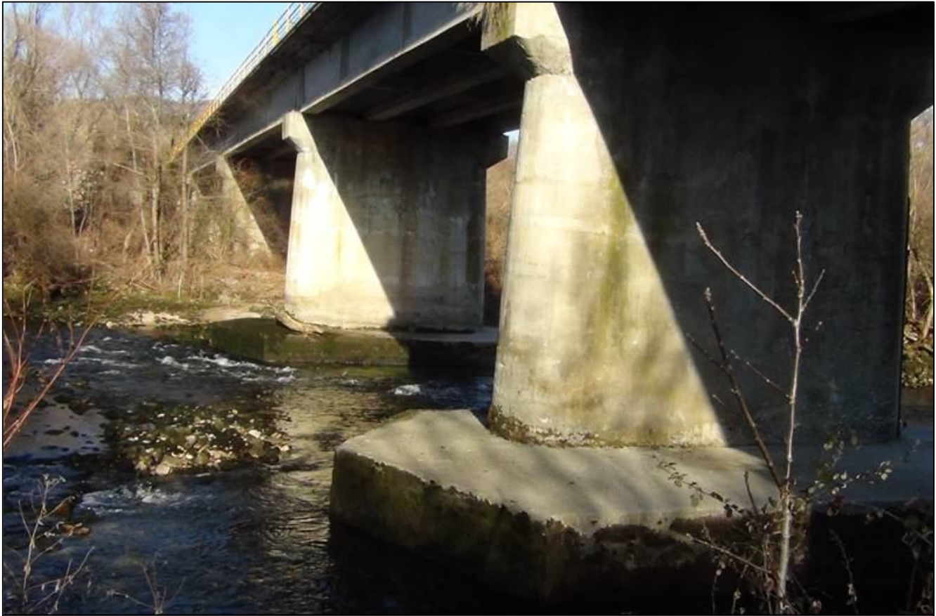
Φώτο 13: Κεφαλόδεσμοι ή πέλδια θεμελίωσης εντός της κύριας ροής του Νέστου.
