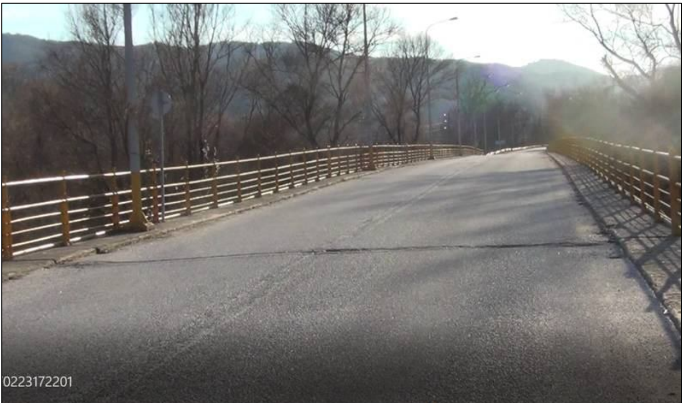
Φώτο 14: Βέλος κάμψης 3 ου φατνώματος λόγω απώλειας προέντασης και ρηγματωμένων δοκών ανωδομής.
