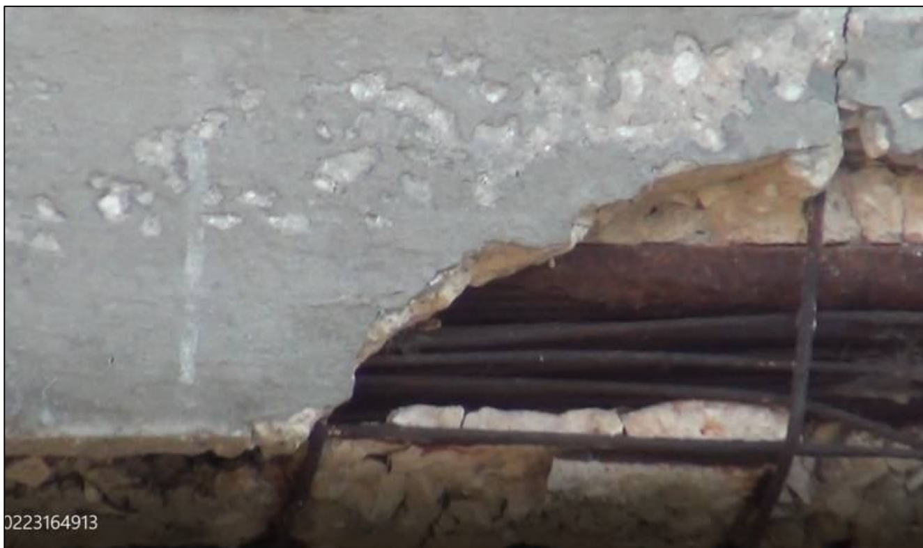
Φώτο 5: Κατακόρυφη ρωγμή δοκού εντοπισμένη σε θέση διάβρωσης τενόντων. Λεπτομέρεια: διακρίνεται τμήμα του οξειδωμένου και κατεστραμμένου σωλήνα περιβλήματος των συρμάτων του τένοντα.
