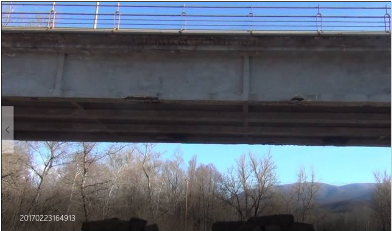
Φώτο 1: 3 ο Φάτνωμα γέφυρας. Κατακόρυφες ρωγμές σε θέσεις απώλειας προέντασης.
