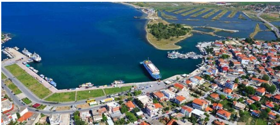
Εικόνα 2-3: Αεροφωτογραφία λιμένα Κεραμωτής (Πηγή: Διαδίκτυο)
