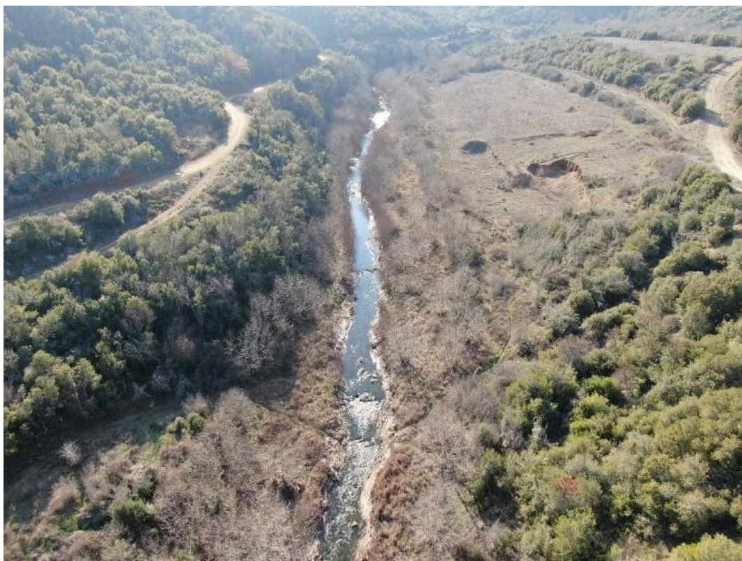
ΦΩΤ. 3-33: Θέση κατασκευής φράγματος ανάσχεσης WB.
