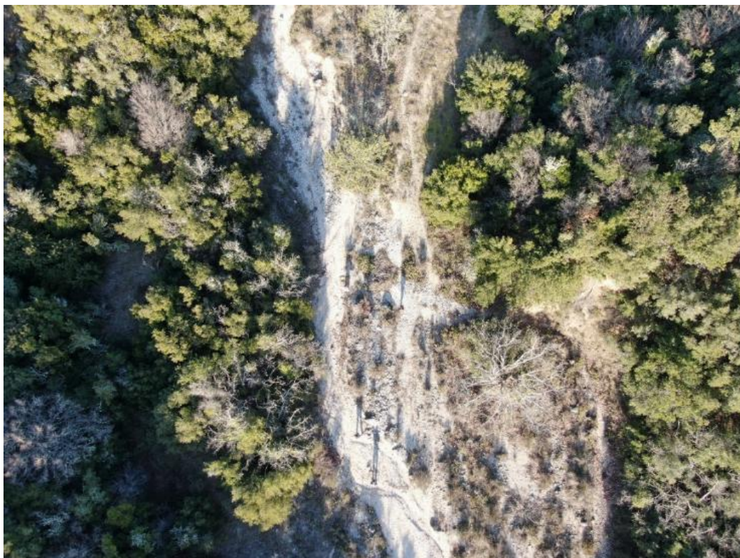
Φωτ. 3-30: Θέση κατασκευής φράγματος ανάσχεσης DC.
