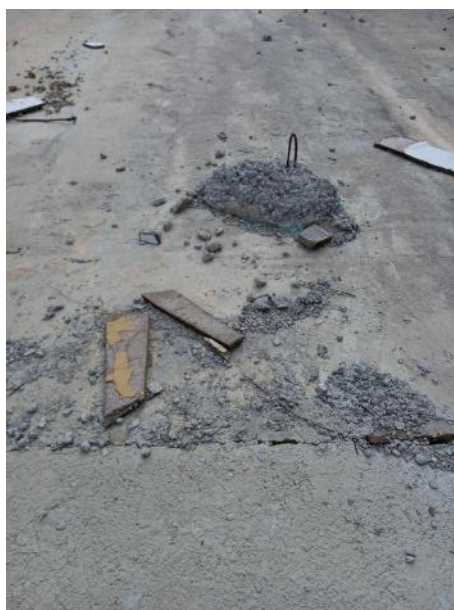
Φωτ. 3-10, 3-11, 3-12 και 3-13: Υφιστάμενη κατάσταση εισόδου και καναλιού υπερχειλιστή.
