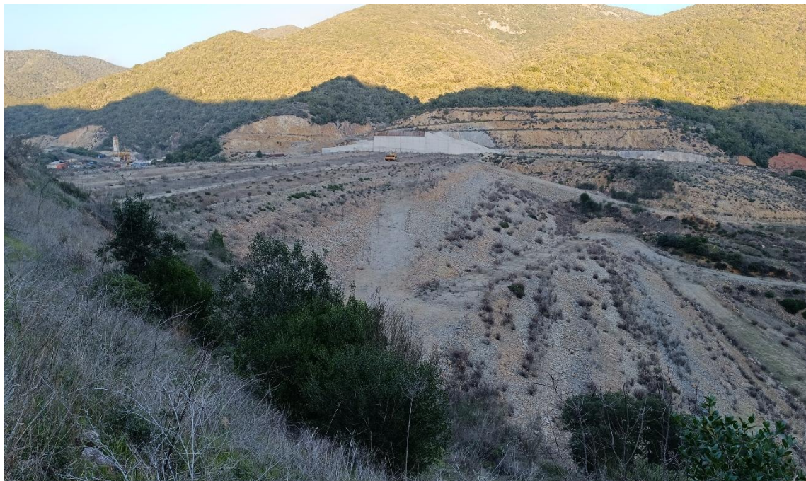
Φωτ. 3-24: Κατάσταση οδών επί του κατόντη πρσανούς του φράγματος.
