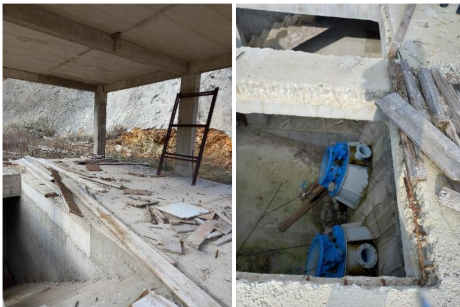
ΦΩΤ. 3-16, 3-17, 3-18 και 3-19: Υφιστάμενη κατάσταση κτηρίου δικλίδων.
