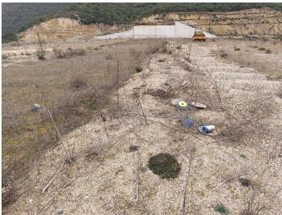
Φωτ. 3-7, 3-8 και 3-9: Υφιστάμενη κατάσταση καλωδίων των ηλεκτρικών πιεζομέτρων
