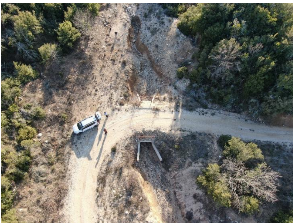
Φωτ. 3-29: Θέση κατασκευής φράγματος ανάσχεσης DB.
