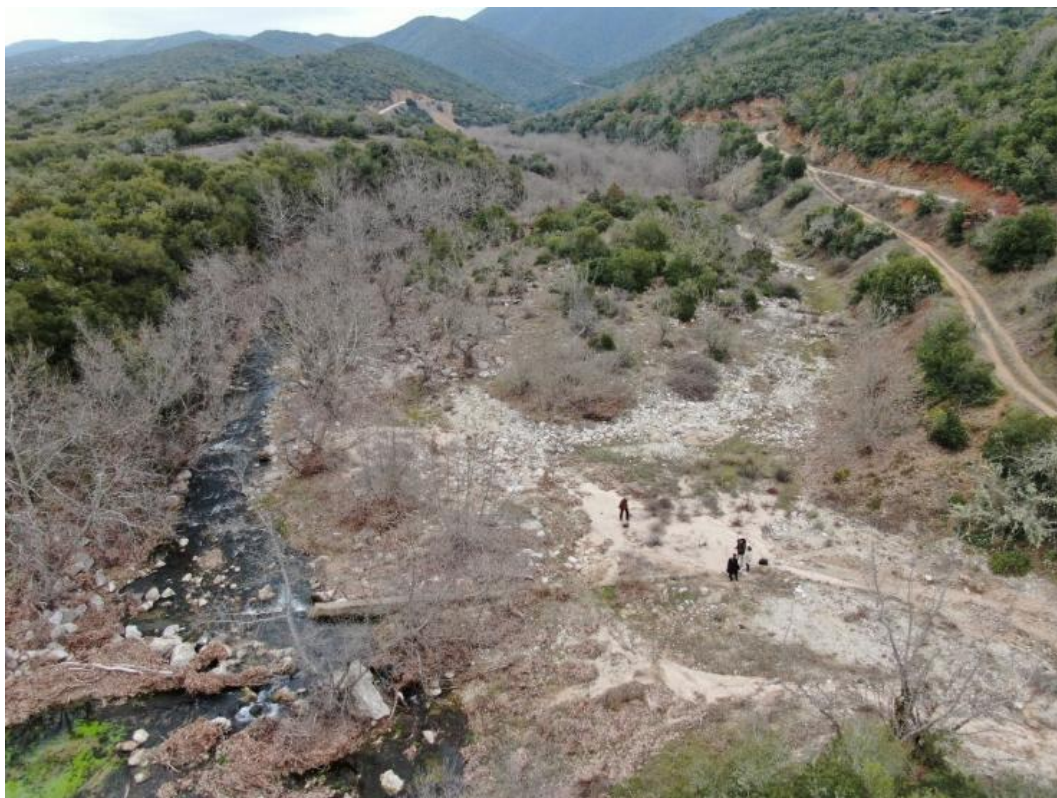
ΦΩΤ. 3-32: Θέση κατασκευής φράγματος ανάσχεσης WA.
