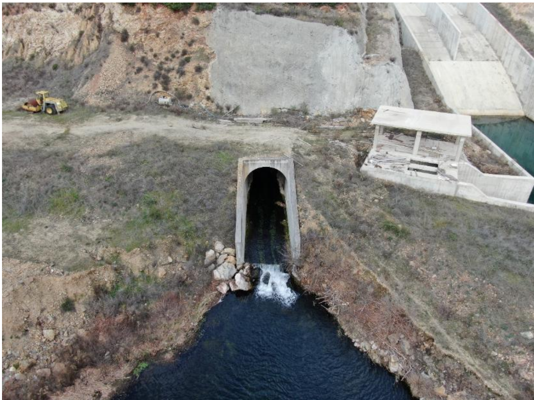
Φωτ. 3-35: Έξοδος σήραγγας εκτροπής.
