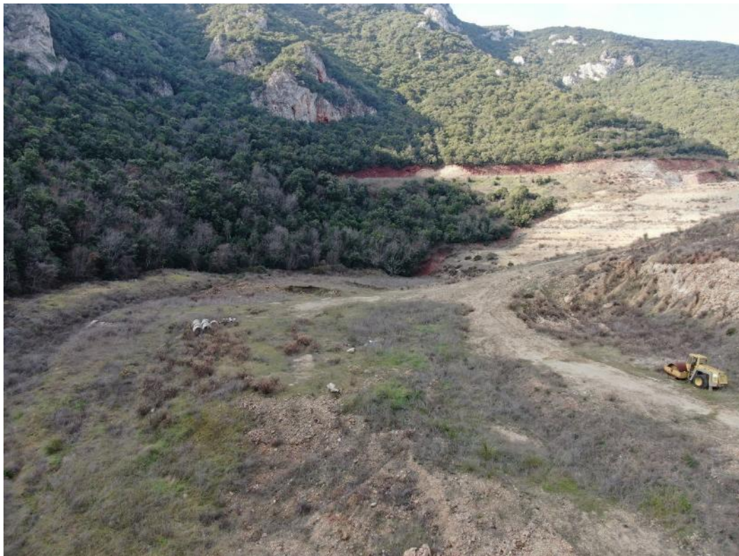
Φωτ. 3-21: Περιοχή επέκτασης τσιμεντοσωλήνα διηθήσεων.
