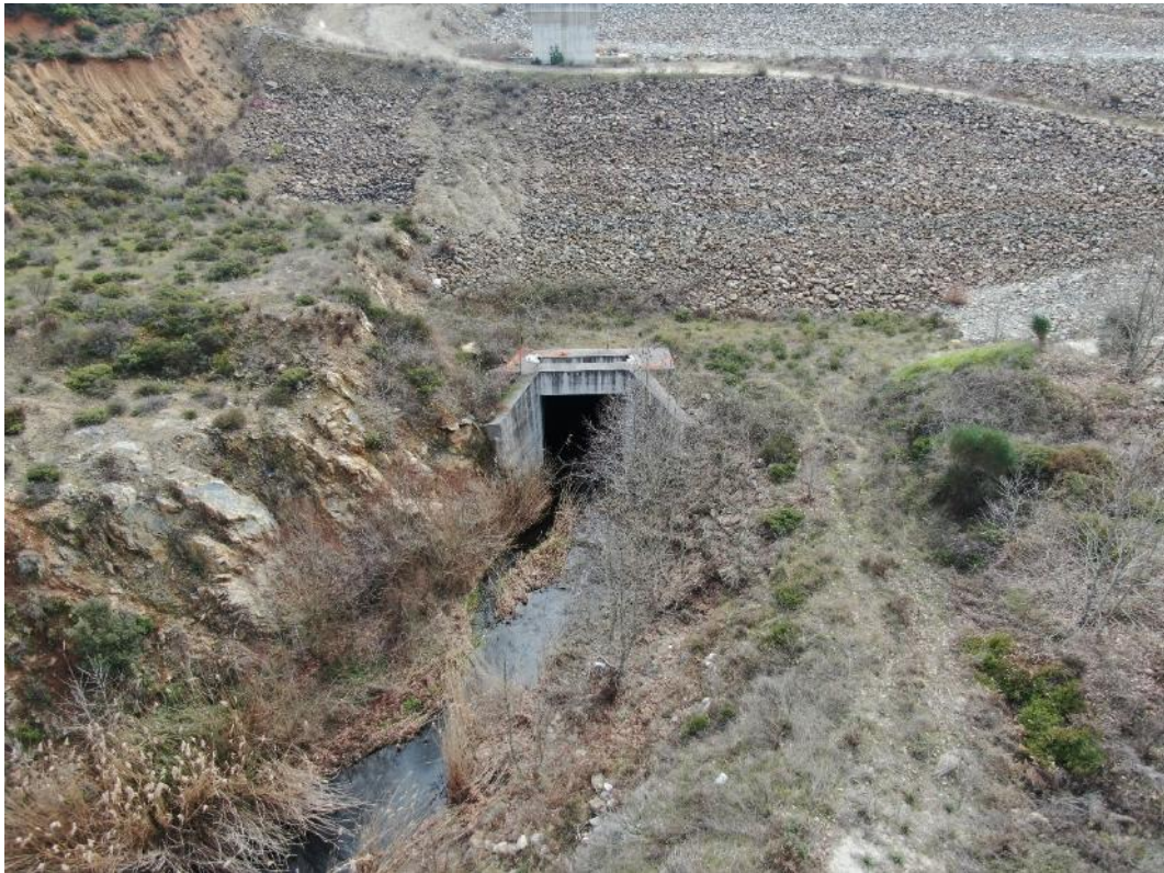
Φωτ. 3-34: Είσοδος σήραγγας εκτροπής.
