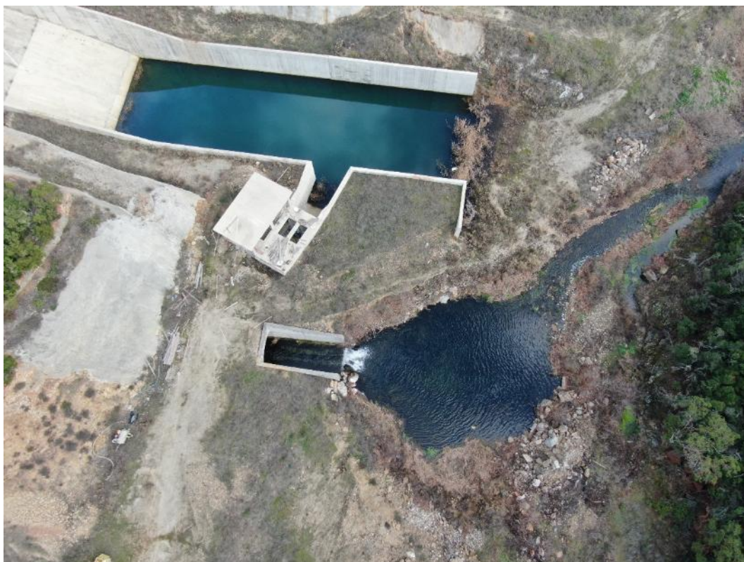
ΦΩΤ. 3-20: Υφιστάμενη κατάσταση περιοχής κατάντη της σήραγγας εκτροπής και του υπερχειλιστή.
