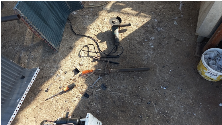
Φωτο 1.: Αφαίρεση χάλκινων σωληνώσεων από ψυκτική κύκλωμα
