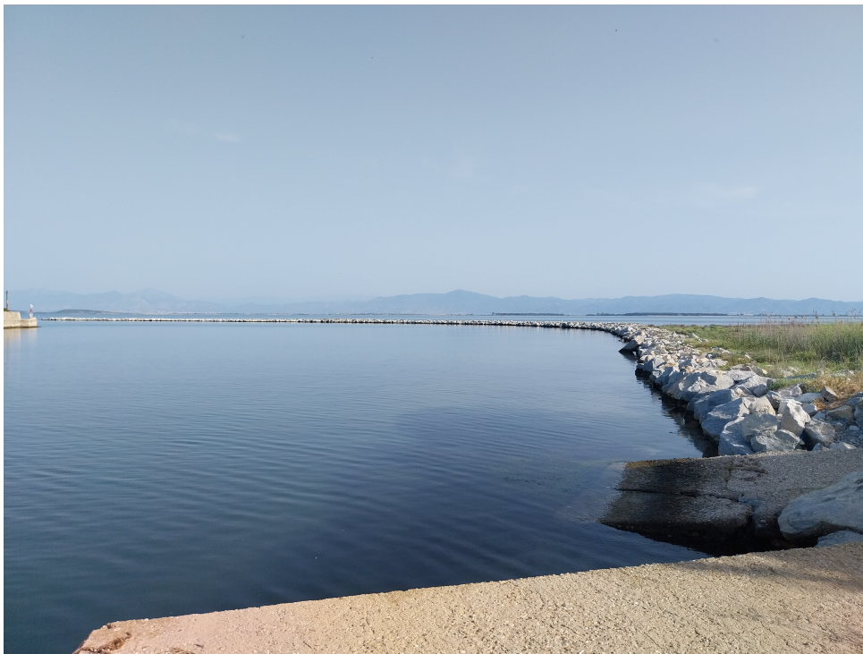
Φωτογραφία 5. Λιμενοβραχίονας αλιευτικού καταφυγίου Φαναρίου
