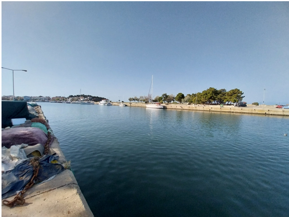
Φωτογραφία 4. Κρηπιδώματα αλιευτικού καταφυγίου Φαναρίου
