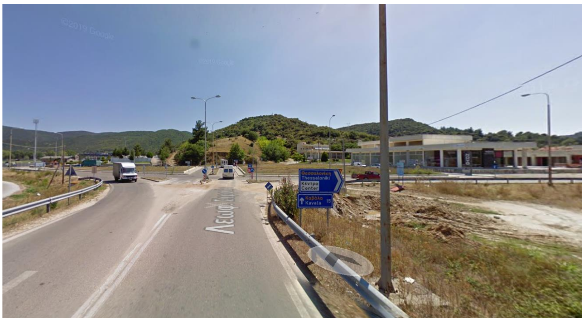
Εικόνα 5. Συμβολή τον ισόπεδο κόμβο επί της Λεωφόρου Σερρών (Πηγή: Google Street View)
