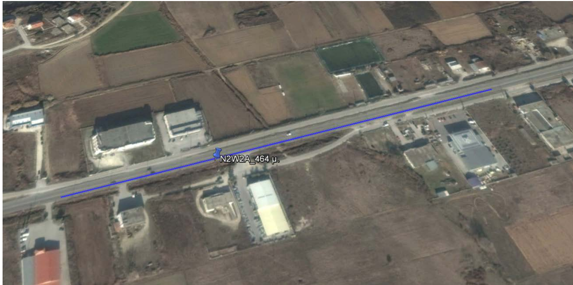
Εικόνα 2: Τοποθέτηση ΣΑΟ τύπου N2W2A
