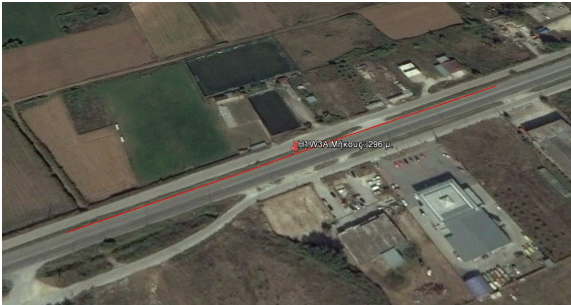
Εικόνα 1: Τοποθέτηση ΣΑΟ τύπου Η1W3Α
