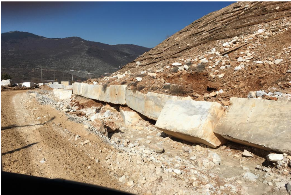
φ3.2 νερογλυφές στον πόδα του πρανούς του λατομείου (ημερομηνία φωτογραφίας 1/3/2021)
