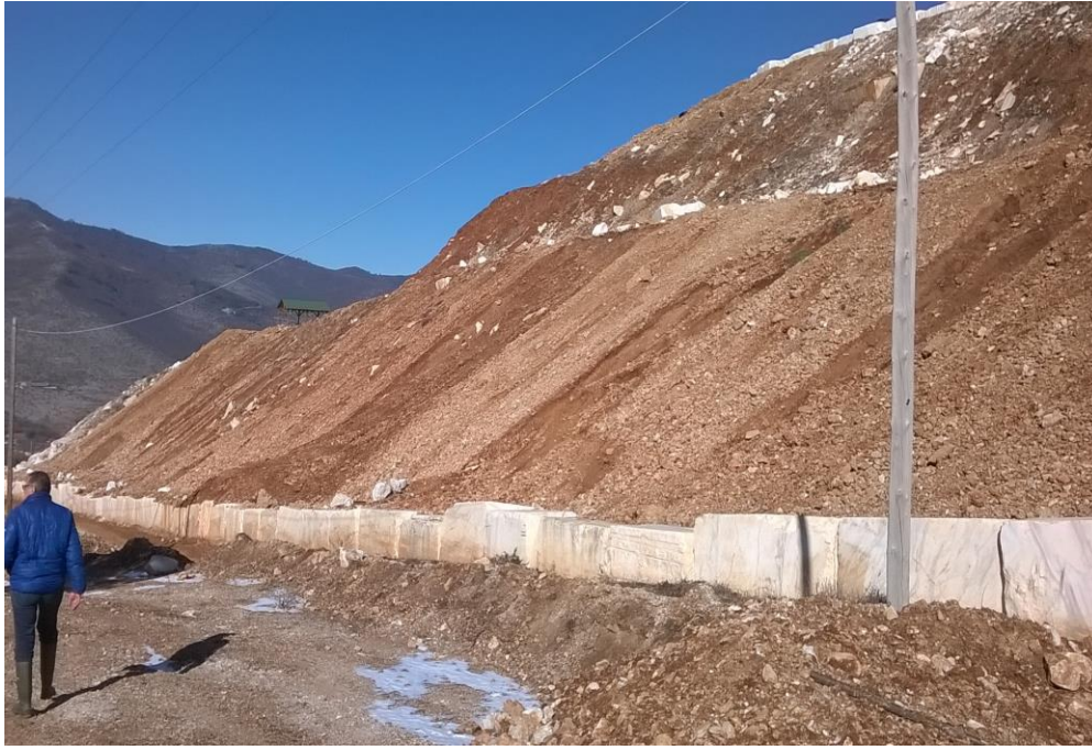
φ3.1 πόδας πρανούς λατομείου (ημερομηνία φωτογραφίας 21/2/2018)
